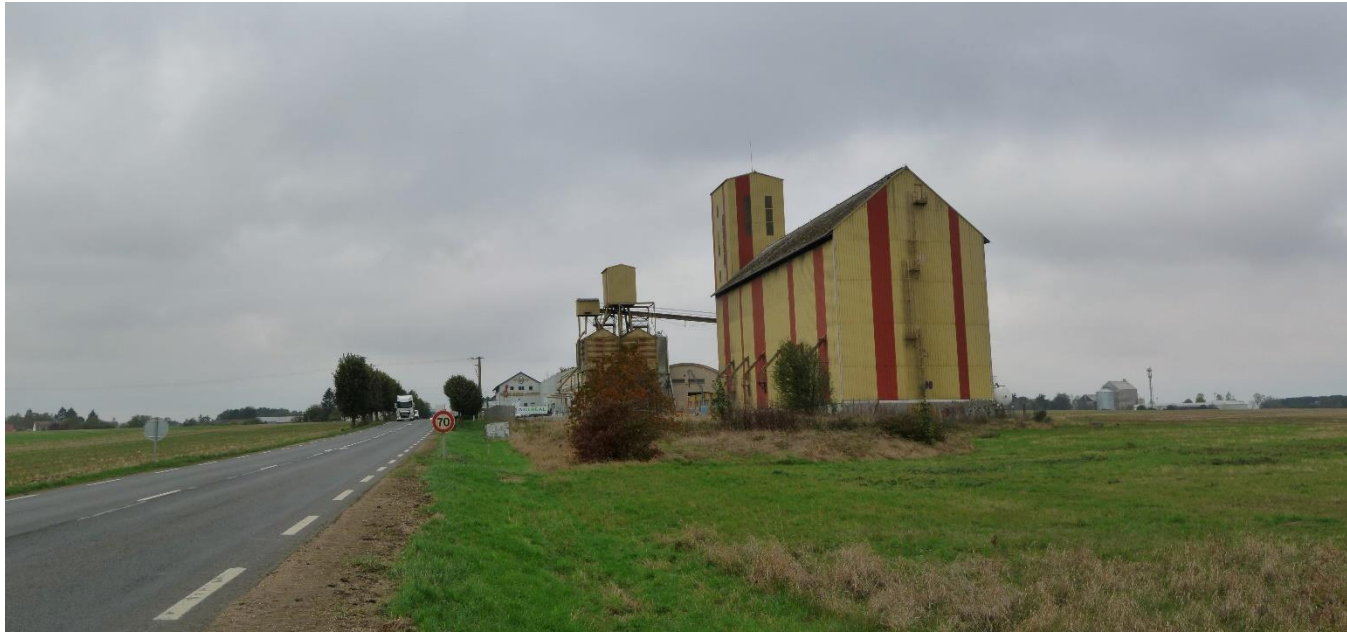
Photo 28 : Silo et bâtiments d'activités à l'entrée de ville d'Ouzouer-le-Marché, jouxtant l'emprise du projet (Source : IEA, 2020)
