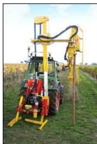
Photo 2 : Exemple d'enfoncement-pieux (Source : TOTALENERGIES – Rabaud SARL)
